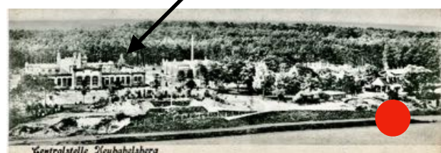
Luftbild von 1910 mit Haupt- und Nebengebäuden
