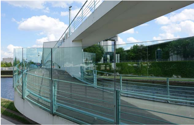
Eine unsichtbare Barriere für Vögel – Glaswand an der Fußgängerbrücke des Bundeskanzleramtes.
